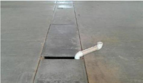
**Atenção!** O fornecimento de água e deságue é feito por canaletas técnicas que cruzam o pavilhão de ponta a ponta. Não existe tubulação de esgoto no interior do pavilhão.
